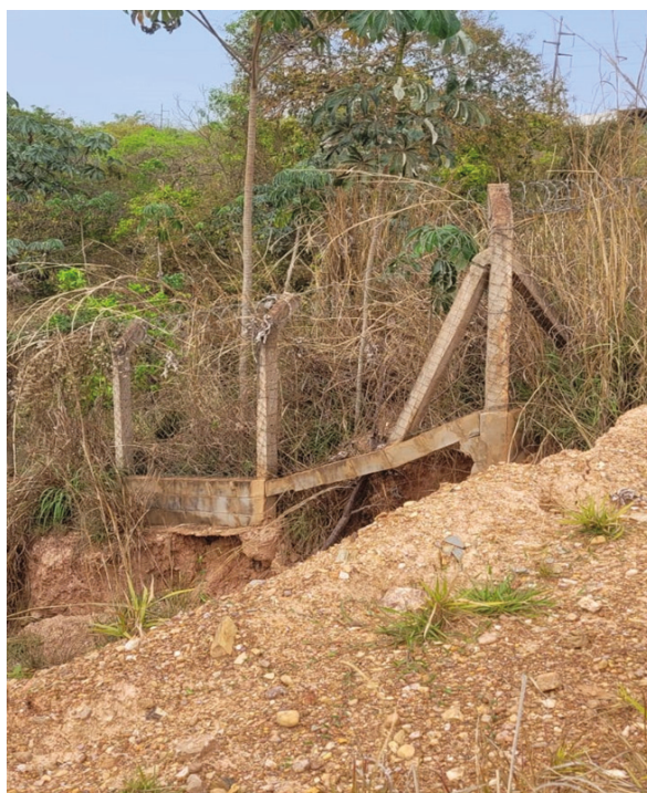
Figura 11 – Imagem da erosão no aterro mais a cerca suspensa.
