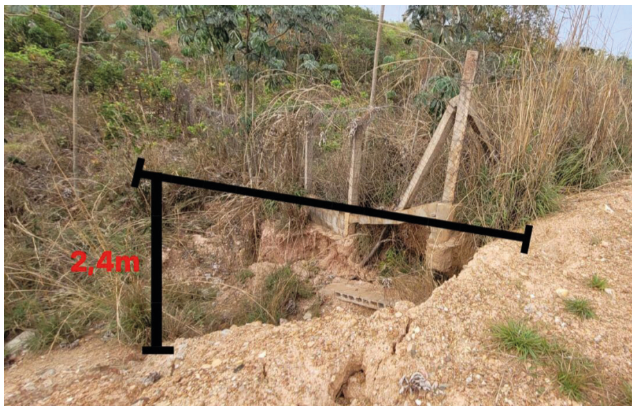
Figura 8 – Imagem da erosão no aterro e abaixo cerca, explicitando a altura.
