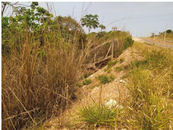
Figura 12 – Imagem da erosão no aterro e a cerca suspensa com vista do pavimento da avenida de acesso ao Campus.
