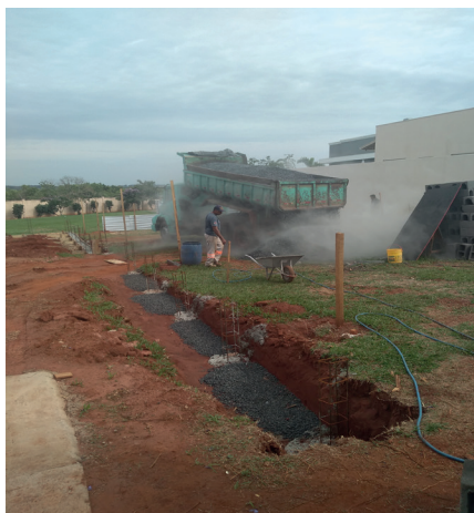
Figura 06: Obra residencial – Condomínio Fechado Uberaba MG
