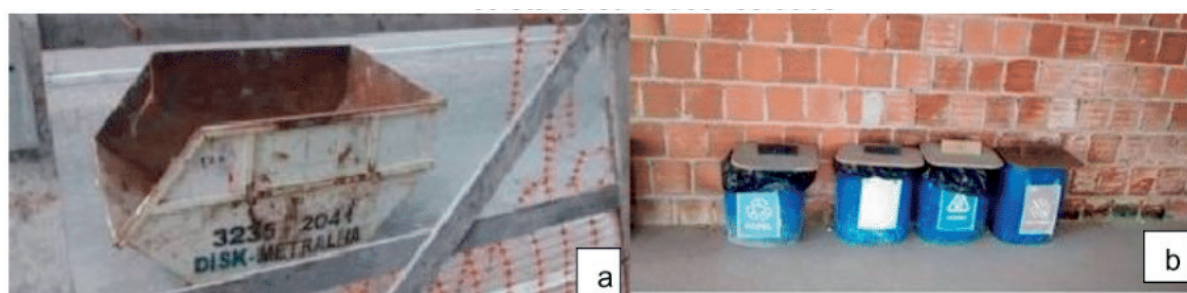
Figura 3 – Destino dos resíduos sólidos a) Caçambas estacionária b) Bombonas para coleta seletiva dos resíduos
