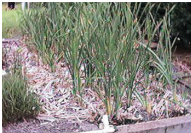
Figura 7 - Leito retangular (4x1m). Pode-se verificar a existência do material de suporte e linha de distribuição.
