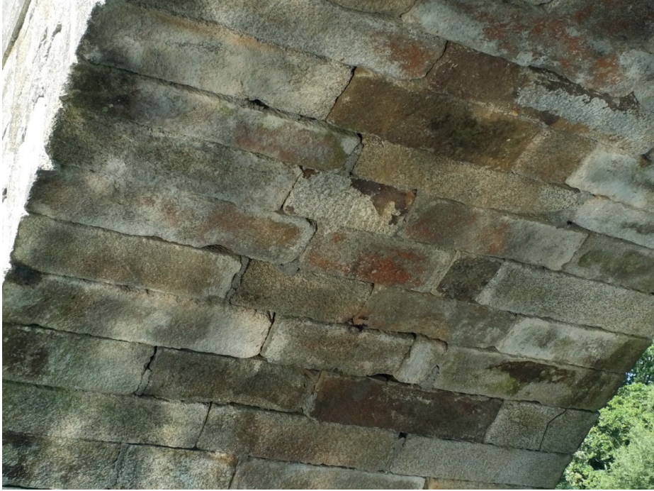
Figura 8: Vista general del alzado aguas abajo del Puente de Brandomil, en imagen captada con el dron multi rotor empleado en la inspección de este artículo (fotografía del autor).
