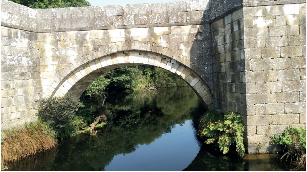
Figura 4: Vista general de uno de los arcos mayores del Puente de Brandomil, en imagen captada con el dron multi rotor empleado en la inspección desde el lado aguas abajo del Puente (fotografía del autor).
