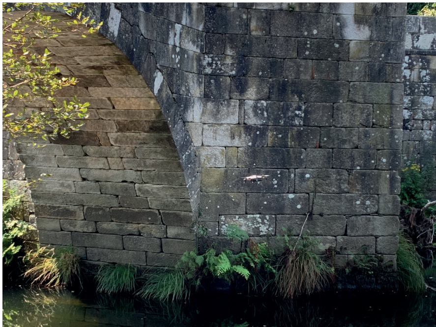
Figura 7: Drone multi rotor empleado en la inspección del Puente de Brandomil, aproximándose al alzado aguas arriba del Puente, para la inspección de diversos elementos constitutivos (fotografía del autor).
