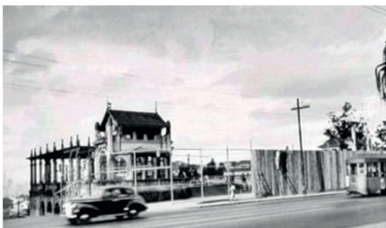
Figura 3: A demolição do Belvedere.
