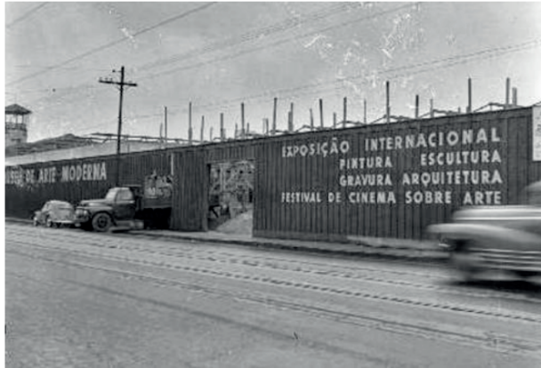
Figura 5: Construção do pavilhão para a 1ª Bienal Internacional de Arte, 1951.
