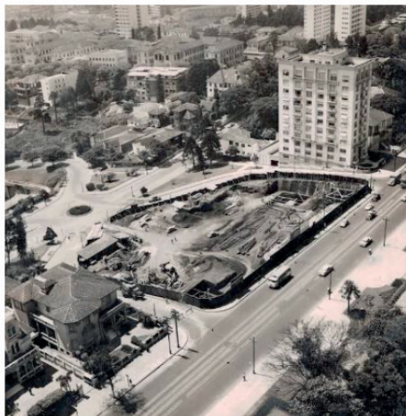
Figura 9. O terreno 1578 da avenida paulista após a demolição do pavilhão da I Bienal
