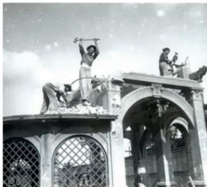
Figura 2: A demolição do Belvedere.
