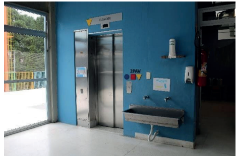
Figura 16: Elevador da escola.
