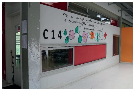
Figura 10: Corredores laterais da escola.
