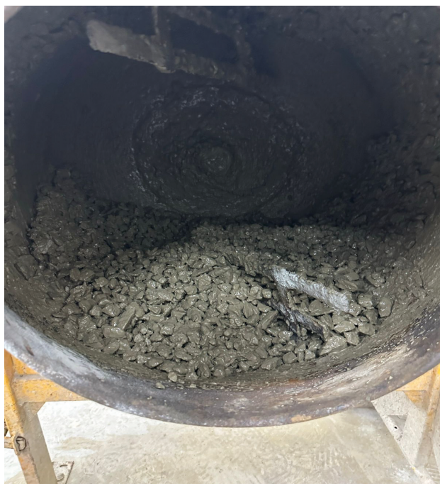
Figura 8 – Confeção do concreto
