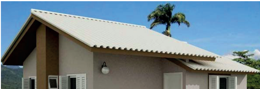
Figura 15 – Telha de Fibrocimento
