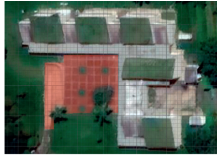
Figura 2: Espacio plazoleta edificio Naranjos (E2)
