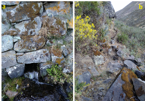
Imagen 2: (a): Desfogue de agua del reservorio Kutaya, (b): Canal de riego que se extiende desde el reservorio de Kutaya.
