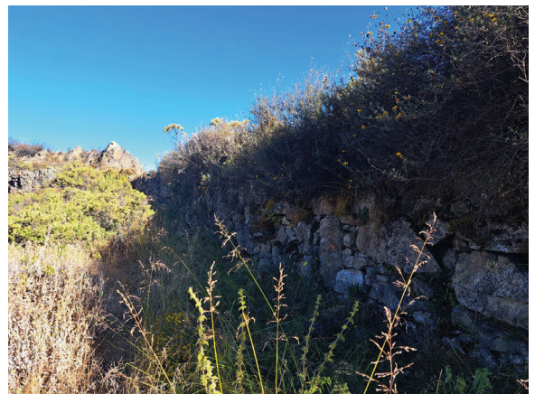
Imagen 7: Muro de piedra de unos 2 metros de alto, presenta un largo aproximado de 100 metros.
