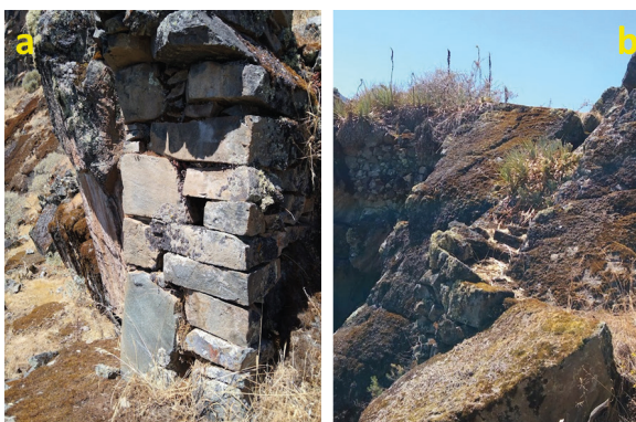
Imagen 12: (a) Vista de pared de ingreso a la zona de las viviendas de Rafelo, (b) escalinatas de ingreso en la zona de viviendas de Rafelo.
