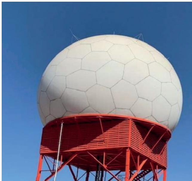
Figura 10 — Ilustração de um radome
