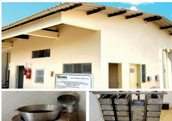
Figura 1 – Estrutura arquitetônica padronizada e equipamentos inoxidáveis das agro indústrias familiares, produtoras de queijos de coalho artesanais, no estado do Rio Grande do Norte, Brasil.
