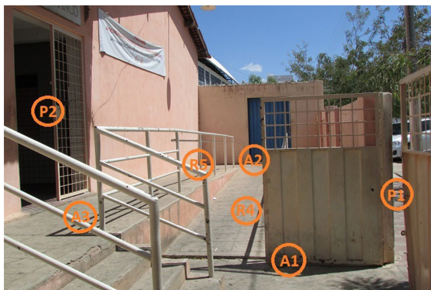
Figura 3 – Portas e rampas de acesso à escola.
