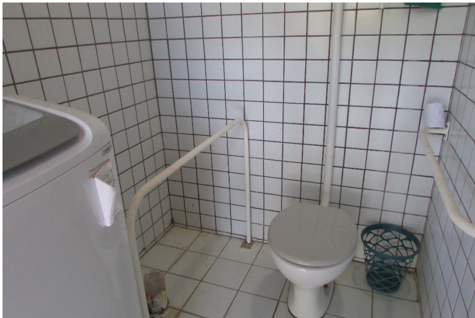
Figura 12 – Banheiro para deficientes.
