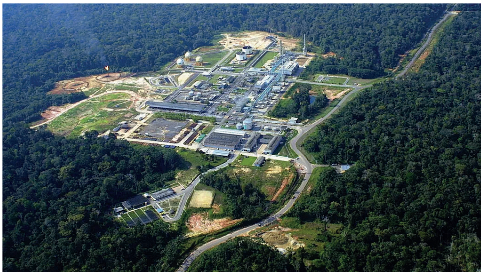
Figura 1. Base de operações em Urucu, Amazonas.
