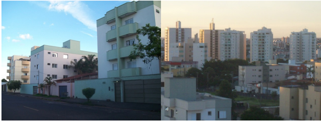
Foto 1 – Edifícios até quatro pavimentos - bairro Santa Mônica / Uberlândia-MG
