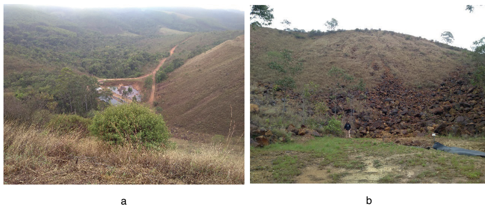
Figura 1: Foto do BF4. A - Vista de cima do talude. B - Vista de baixo do talude.
