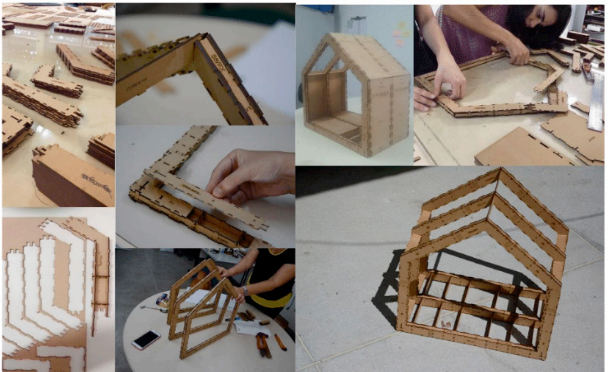
Figura 2: Construção do protótipo em escala de um módulo da Wikihouse .
