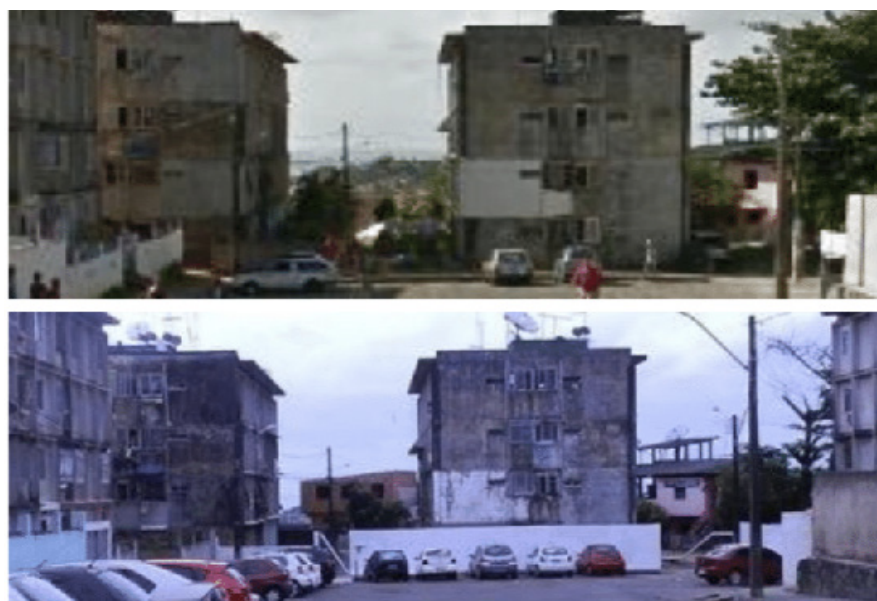
FIGURA 4 – Fotografias do mesmo local revelam construção recente de muro e portão em Colinas de Periperi
