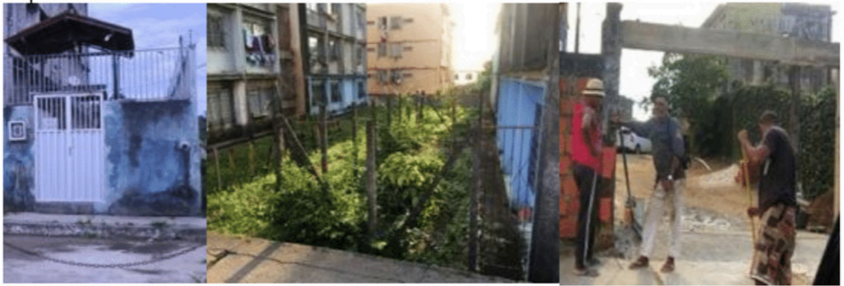
FIGURA 8 – Mosaico de fotos revela modos de fortificação em edifícios de Mirantes de Periperi
