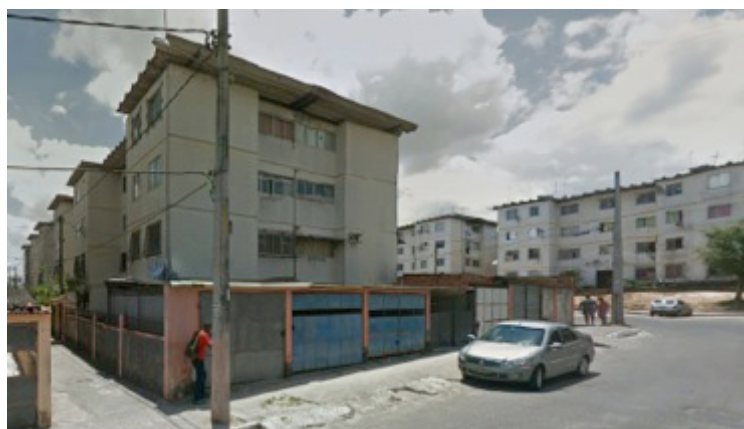
FIGURA 3 – Muro e garagem no conjunto Vista Alegre
