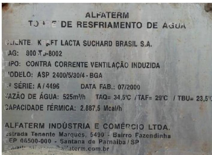
Foto 1 – Placa de Identificação da Torre de Arrefecimento.
