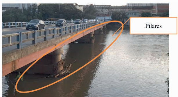
Figura 11 – Ponte Flávio de Miranda Gonçalves
