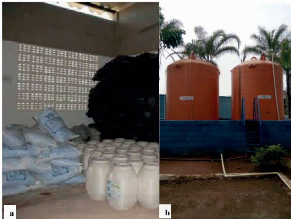
Figura 3: (a) local de armazenamento de sulfato de alumínio em pó em ETA (b) tanque de armazenamento do cloreto de polialumínio (PACl) utilizado pelo DMAE-Uberlândia.
