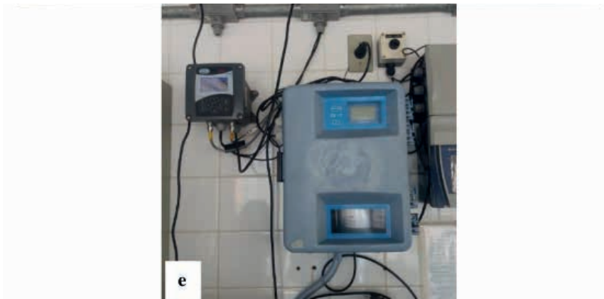
Figura 4: (a) sistema de controle de recepção de água bruta; (b) medidores de pH, cor, turbidez da água bruta e após o processo de coagulação e decantação em tempo real; (c) dosador de cal virgem e PACl; (d) distribuição da cal virgem e PACl na água bruta e (e) painel de controle, dentro do laboratório, que transmite informação de pH, cor, turbidez em tempo real para o operador; na ETA Bom Jardim - Uberlândia.
