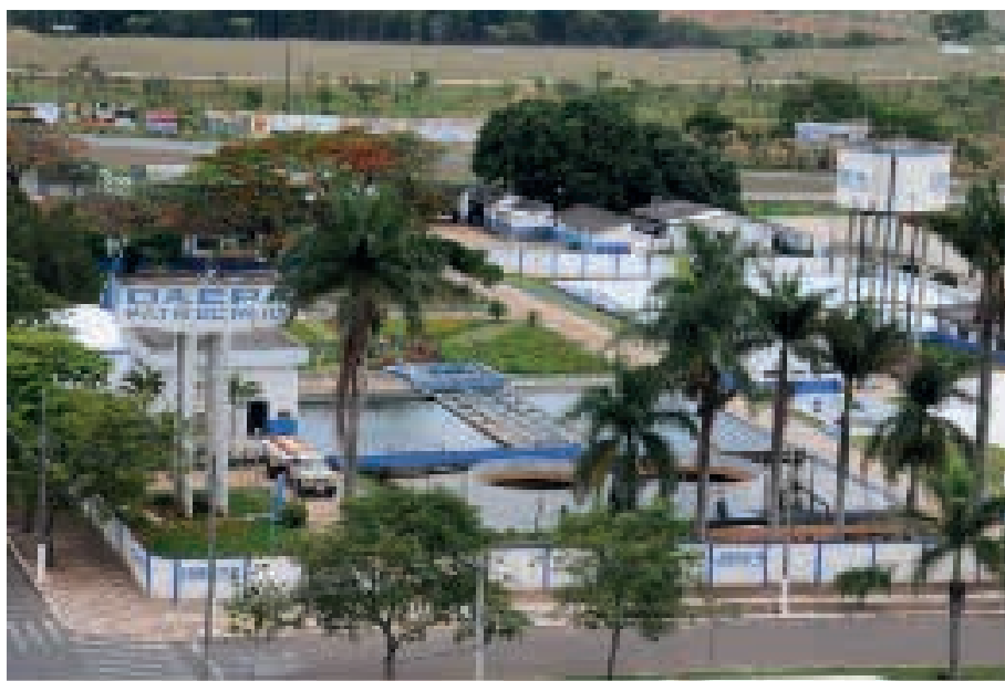
Figura 1: Estação de Tratamento de Água no bairro São Judas Tadeu
