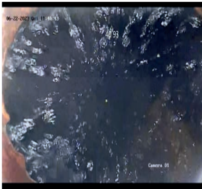
Figura 7: mostra vazamento aos 41 metros de profundidade.
