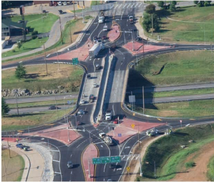
Figura 4: Primeira DDI construída nos Estados Unidos (MODOT, 2013).
