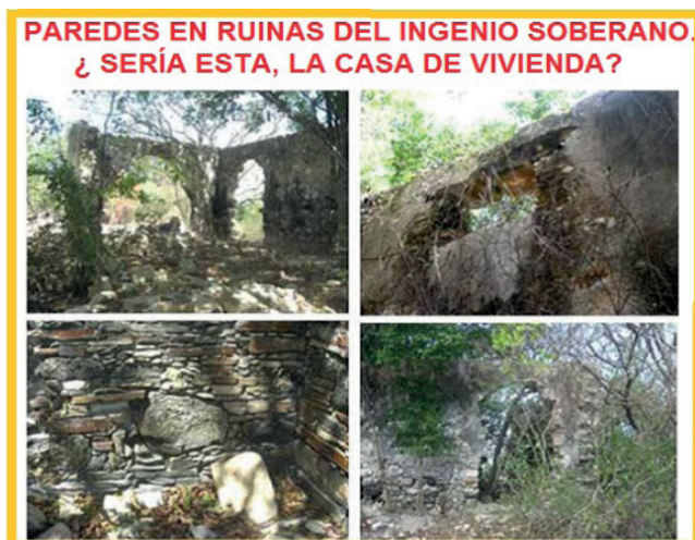
Figura 4- Ruinas actuales del Ingenio Soberano.
