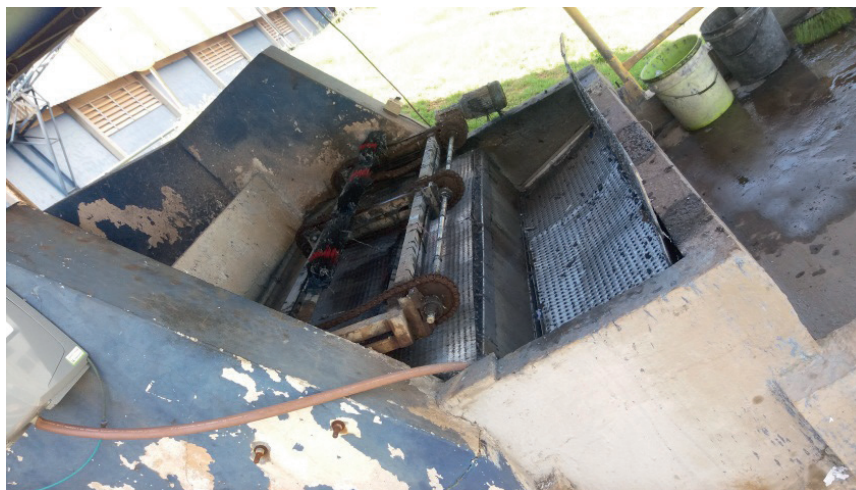
Figura 3: Peneira – Remoção de sólidos grosseiros
