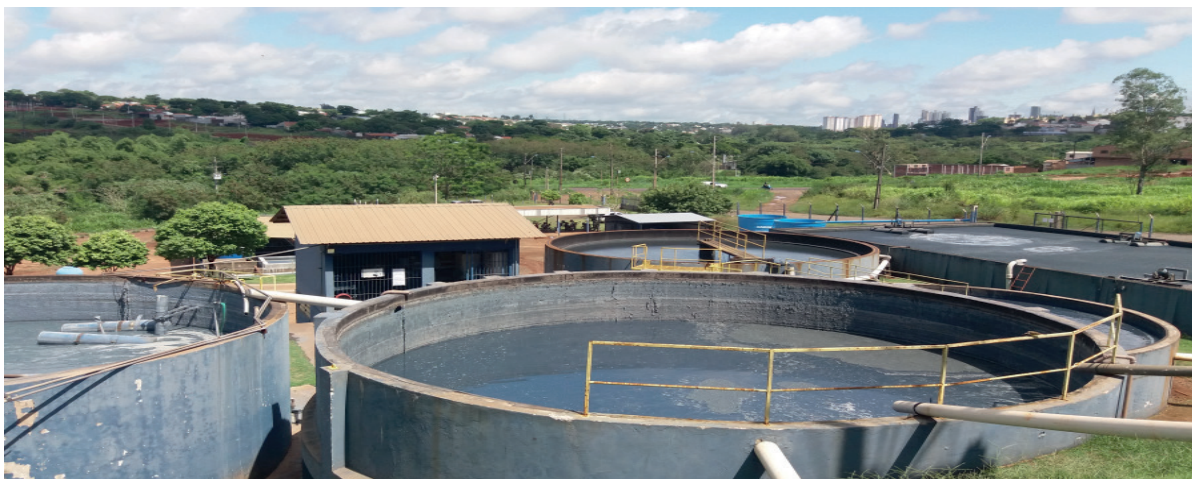
Figura 1: Central de tratamento de efluentes.
