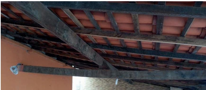
**FIGURA 2.** Viga doblada con fluencia de apoyo
