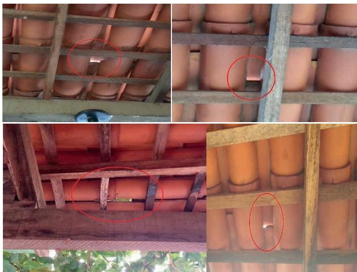
**FIGURA 3.** Baldosas mal colocadas
