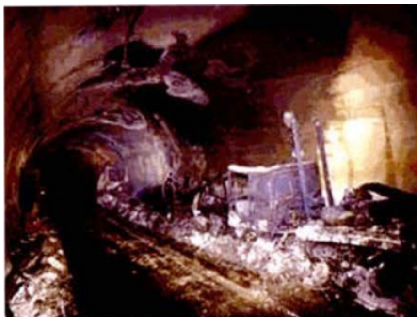
Figura 3. Túnel de Mont Blanc após a tragédia.
