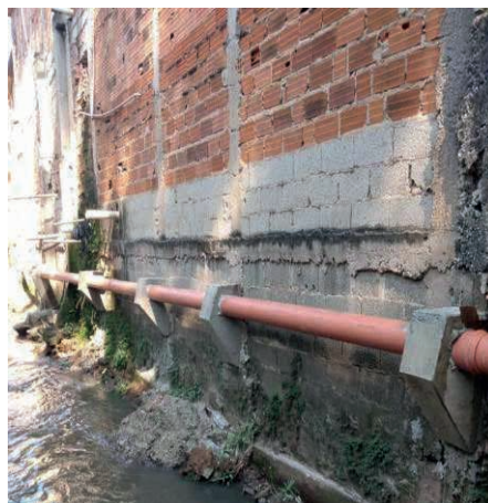
Obras civis para a implantação de redes coletoras e ramais
