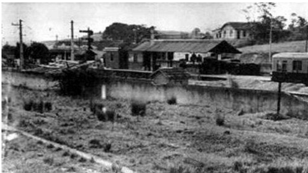
Foto 2 : Antiga estação de Honório Gurgel
