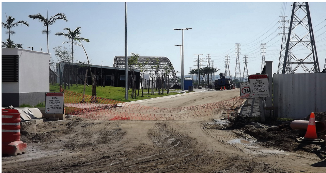
Foto 4: Obra de ampliação do parque de Madureira com retirada da horta urbana
