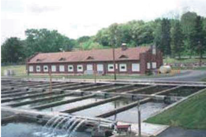
Figura 5. Sistema intensivo de cultivo de trucha en raceways (Tomada de Fragoso y de Ocampo, 2004)
