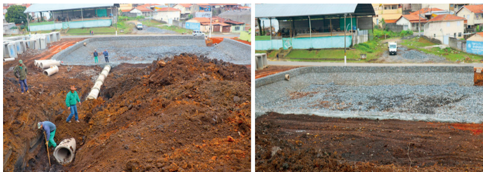
Figura 16: Finalização da bacia de retenção da Av. Eusébio Savaio (Prefeitura Municipal, 16/09/2022).
