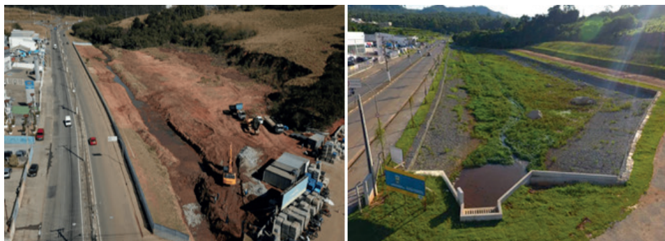
Figura 14: Início da construção do piscinão Califórnia e obra terminada (Jornal mais Bragança - 01/09/2021).
