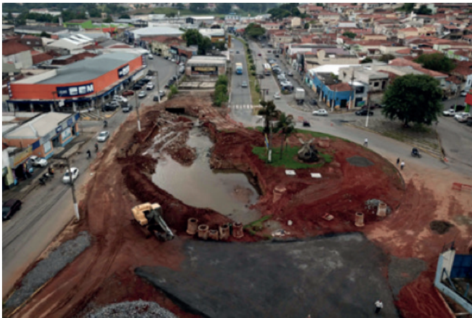
Figura 12: Implantação de aduelas no Ribeirão Lavapés, Praça Chico Major (Jornal em Dia - 22/02/2020).
