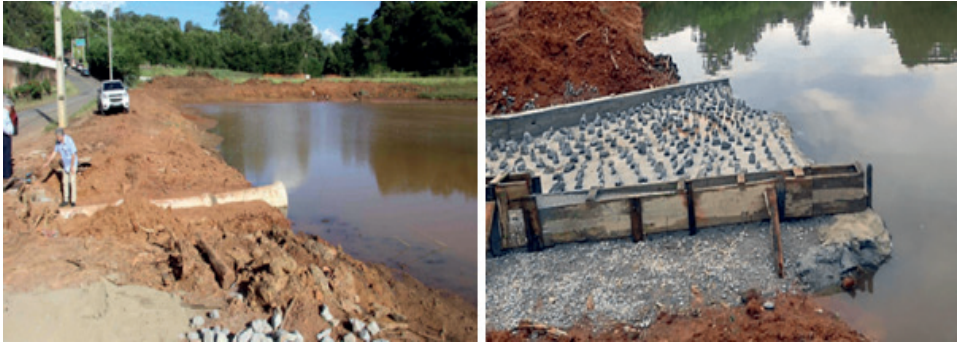
Figura 11: Obras na zona sul da cidade, piscinão Santa Helena (jornal mais Bragança - 20/02/2019).
