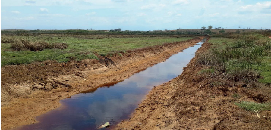
Figura 18. Canal de drenagem escavado em solos turfosos (Organossolos) para rebaixamento do nível freático regional no baixo vale do Rio Macabu. Município de Campos dos Goytacazes, RJ.
