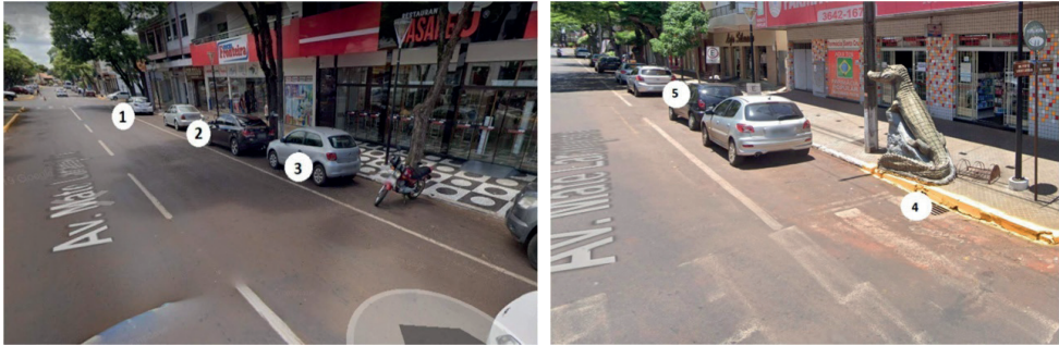
Figura 4 –Indicação das bocas de lobo
