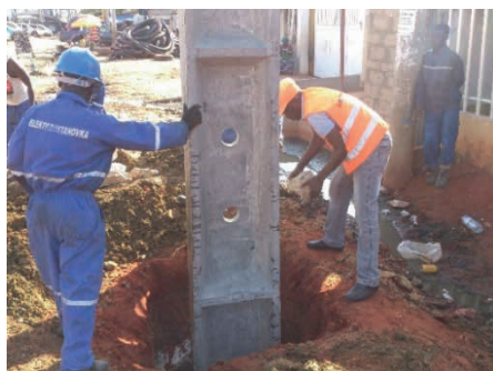
Figura 1. Implantação do poste em betão
