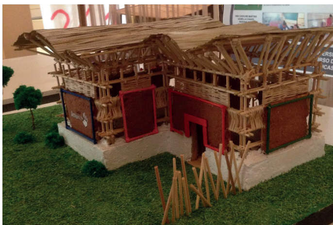
Figura 4 – Casa Arrimo (maquete em taipa, amarração e cobertura de bambu)
