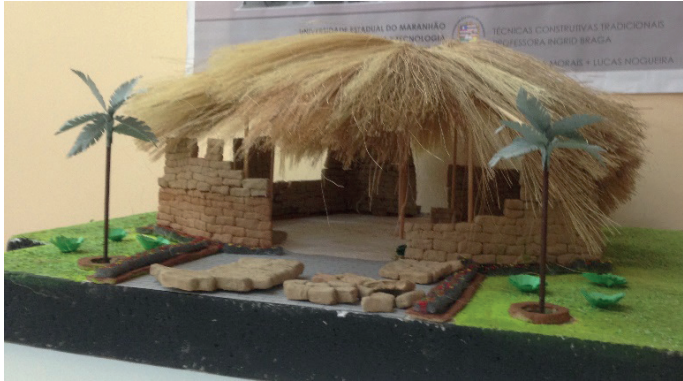
Figura 5 – Espaço Sabear (maquete em adobe e cobertura em piaçava).
