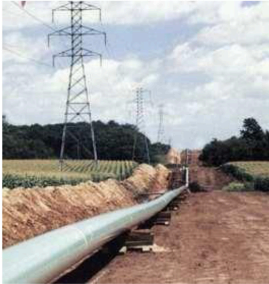
Figura 3: Adutora de aço em construção junto a uma linha de transmissão elétrica em alta tensão. Nesses casos a adutora fica influenciada por interferências eletromagnéticas que precisam ser estudadas, diagnosticadas e eliminadas com a instalação do sistema de proteção catódica.
