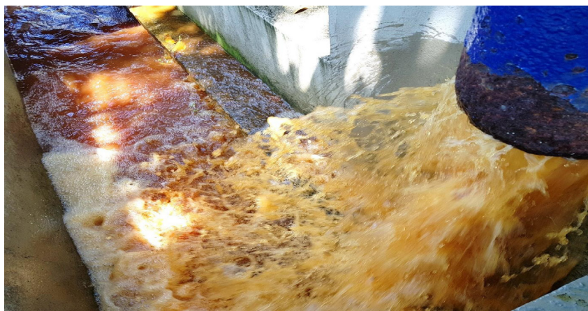
Figura 2: Água de lavagem de filtros da ETA Itaúnas. Fonte: O Autor.
