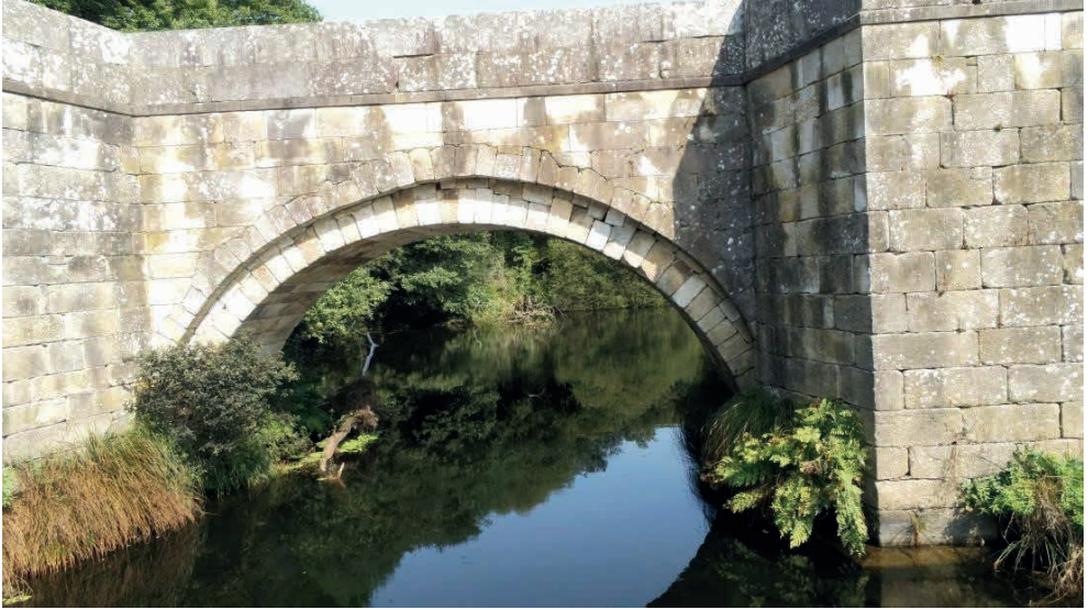
Figura 4: Vista general de uno de los arcos mayores del Puente de Brandomil, en imagen captada con el drone multi rotor empleado en la inspección desde el lado aguas abajo del Puente (fotografía del autor).
