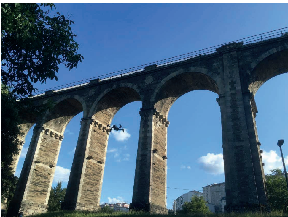
Figura 2: Drone cuadricóptero aproximándose para una inspección sobre el Ponte da Chanca, viaducto ferroviario ubicado en la ciudad de Lugo que el 20 de diciembre de 2021 cumplió 150 años (fotografía del autor).
