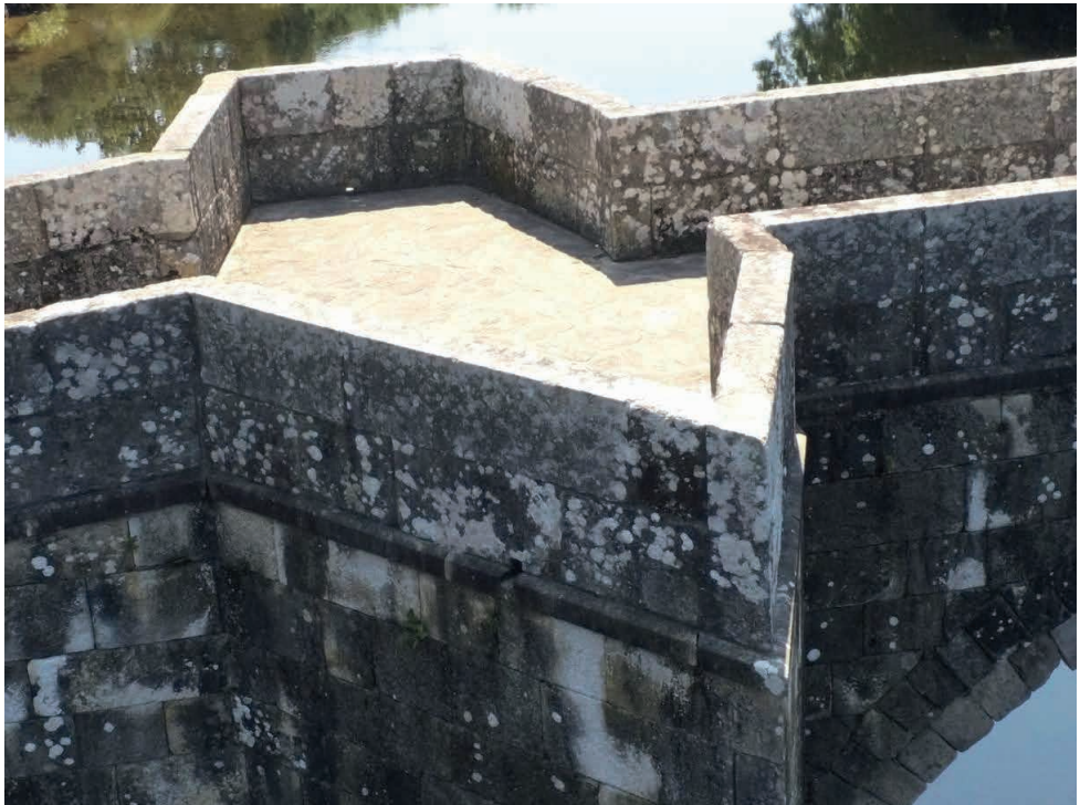
Figura 5: Vista general de la parte superior de uno de los tajamares del Puente de Brandomil, en imagen captada con el drone multi rotor empleado en la inspección (fotografía del autor).
