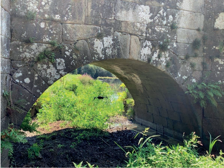
Figura 6: Drone multi rotor empleado en la inspección del Puente de Brandomil, adentrándose en el interior de la bóveda del arco menor para su inspección desde el lado aguas arriba del Puente (fotografía del autor).
