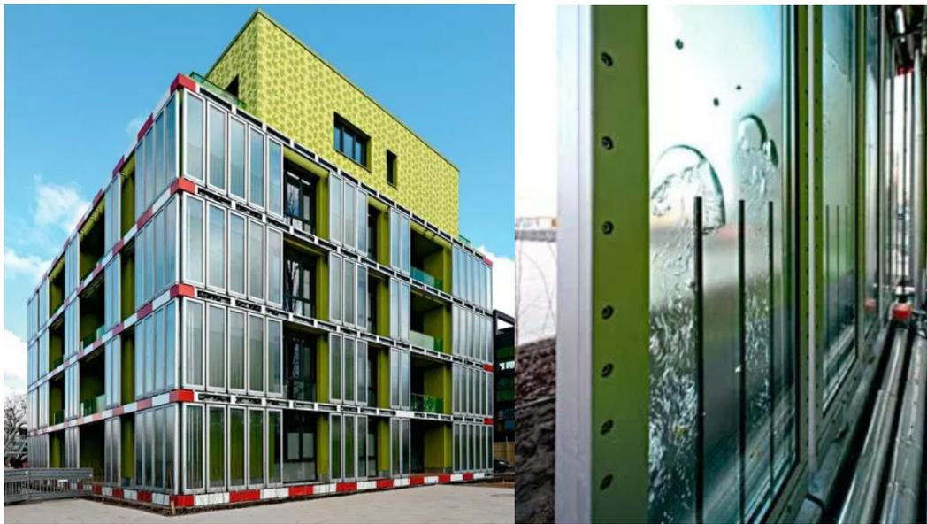
**Figura 1.1** – SolarLeaf: Edifício com fachada recoberta por fotobiorreatores
