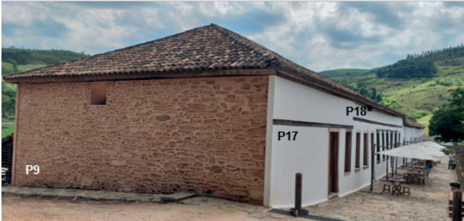
Figura 9. Parede de pedra patrimonial (P9) na Tulha da Fazenda Atalaia construída na técnica canjicado, tendo um cordão de borda saliente em areia e cal e parede. P17 alvenaria em pedra rebocada e P18 Alvenaria em taipa de pilão rebocado. (Fonte: Próprio Autor, 2022).
