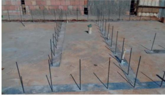
**Figura 8** – Fixação dos arranques (Fonte: SALGADO, 2019)
