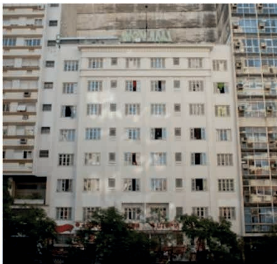
Figura 5: Edifício reabilitado para HIS (2011)
