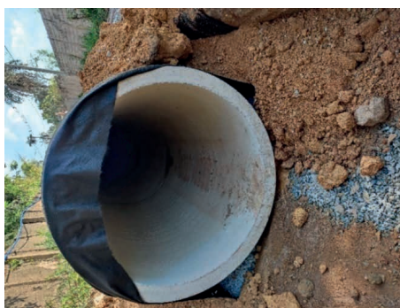
Figura 12 – Tubulação envolta em manta geotêxtil e areia para contenção da tubulação.
