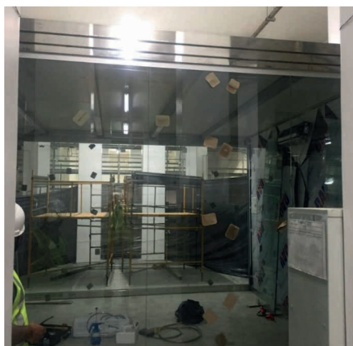
Figura 20 – Instalação das esquadrias de alumínio
