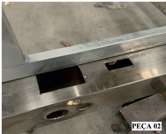
Figura 14 – Furações na viga metálica inferior para passagem do sistema hidráulico
