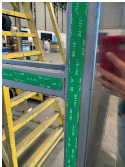
Figura 15 – Utilização de fita dupla face para a fixação das placas de ACM
