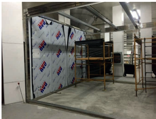
Figura 19 – Montagem do módulo em andamento
