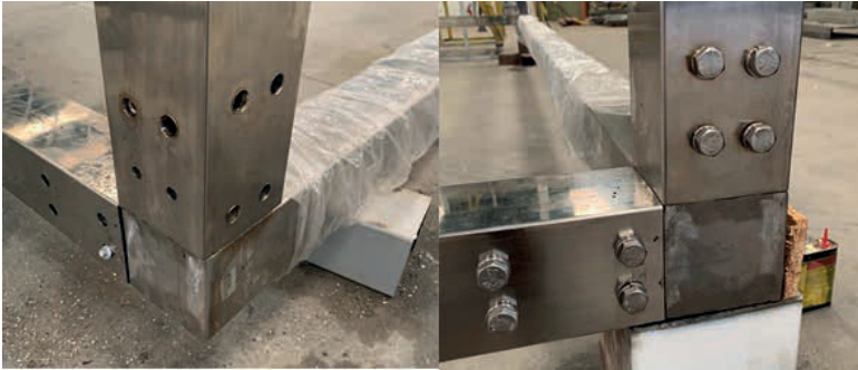
Figura 11 - Furação dos elementos encaixados para a fixação com parafusos
