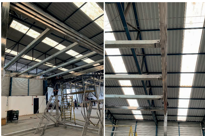
Figura 10 - Montagem da dos barrotes encaixados nas vigas superiores
