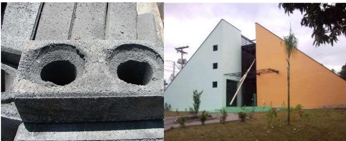
Figura 4: Construção de casa com tijolos fabricados a partir da escória de aciaria
