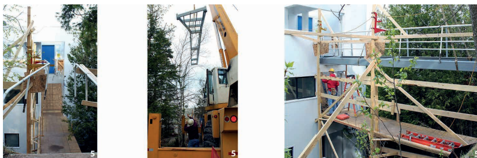
Figura 5. Casa Douglas. Restauração em 2008.
