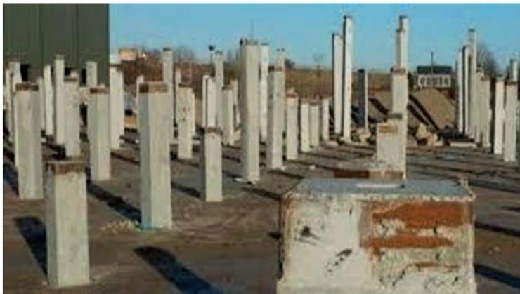
Figura 12: Estacas pré-moldadas de concreto
