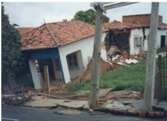
Figura 15: Consequência das patologias na fundação
