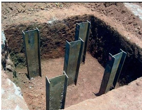
Figura 13: Estacas metálicas
