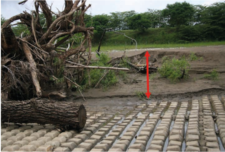
Figura. - 1 Depósito de sedimento en un vertedor lateral.
