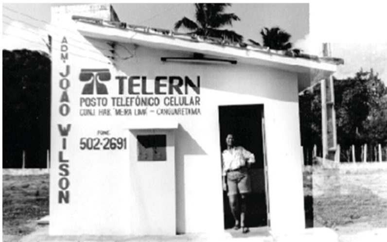
Figura 7- Posto de Serviço com suporte da Plataforma do SMC da Telern na Localidade de Meira Lima, Canguaretama, RN.
